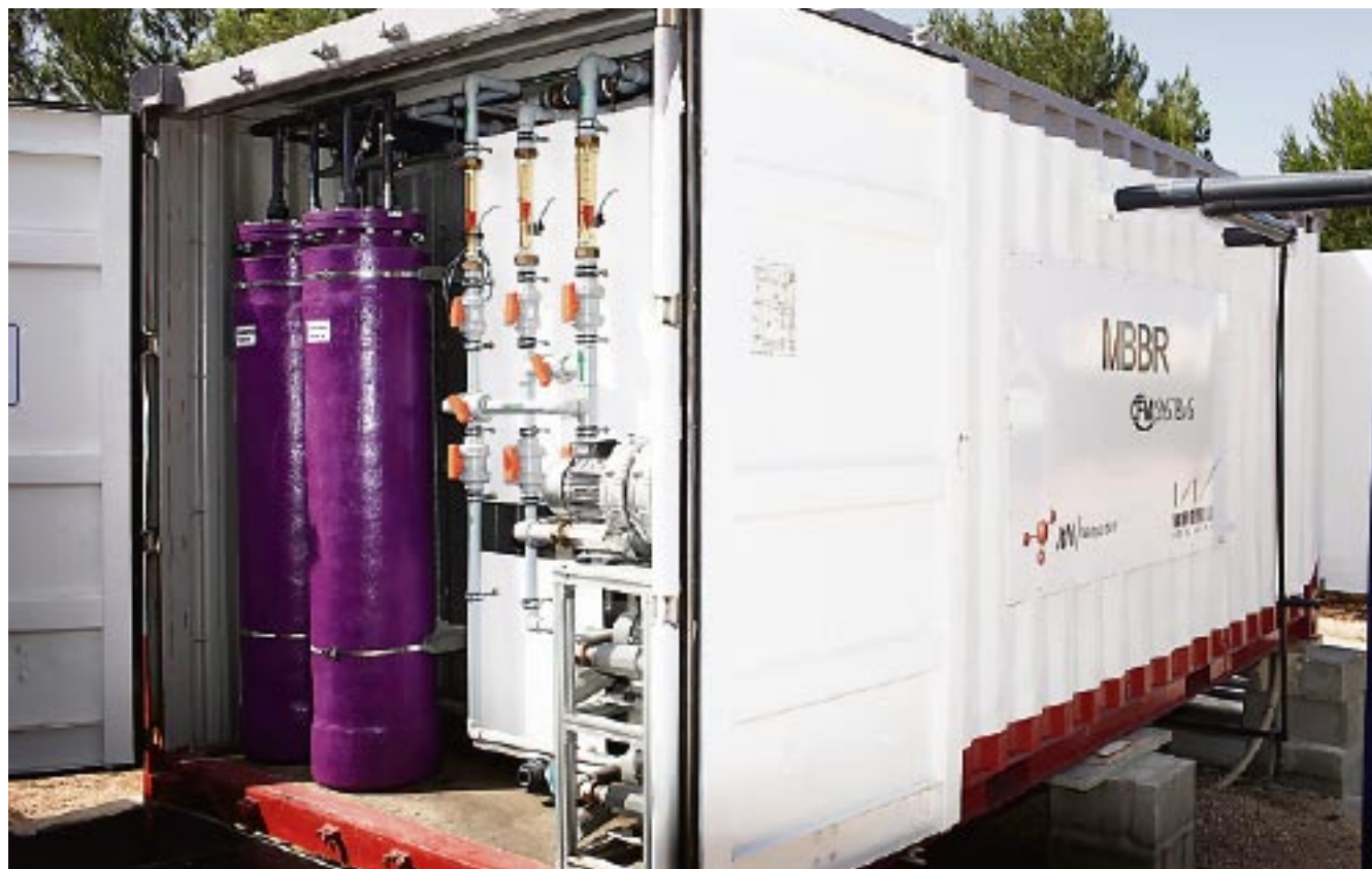
Nanotechnologisch beschichtete Filter machen es möglich: Mini-Kläranlage für den dezentralen Einsatz in abgelegenen Gebieten.
