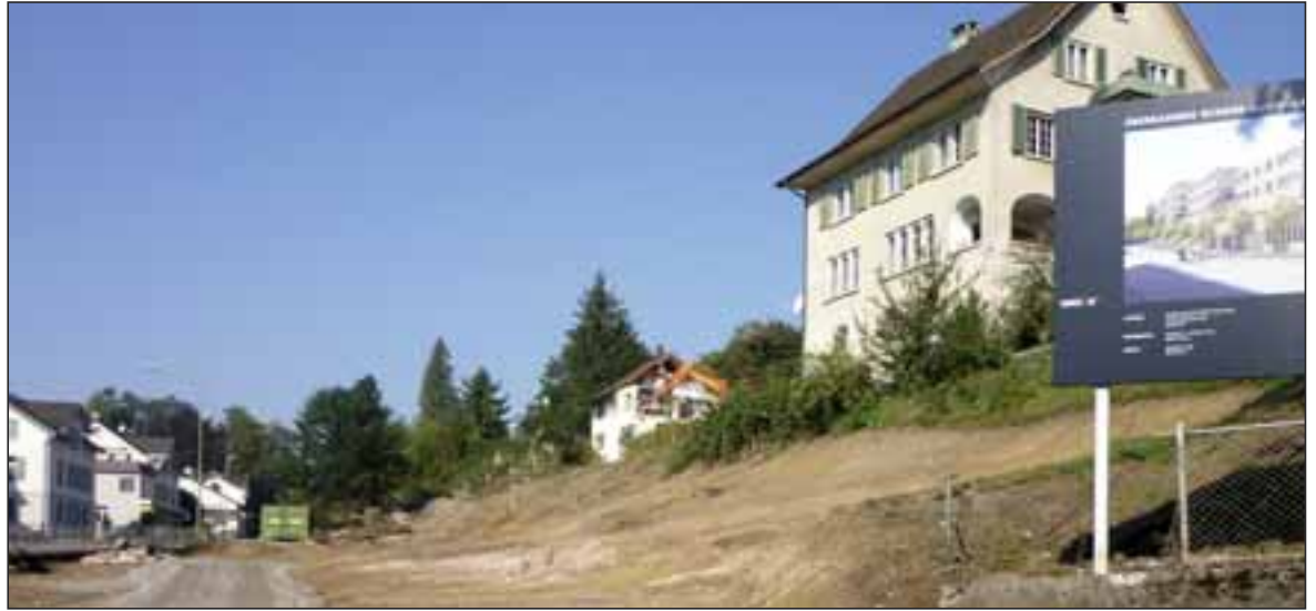
Die Arbeiten für die Überbauung «Schanz» haben bereits begonnen.
