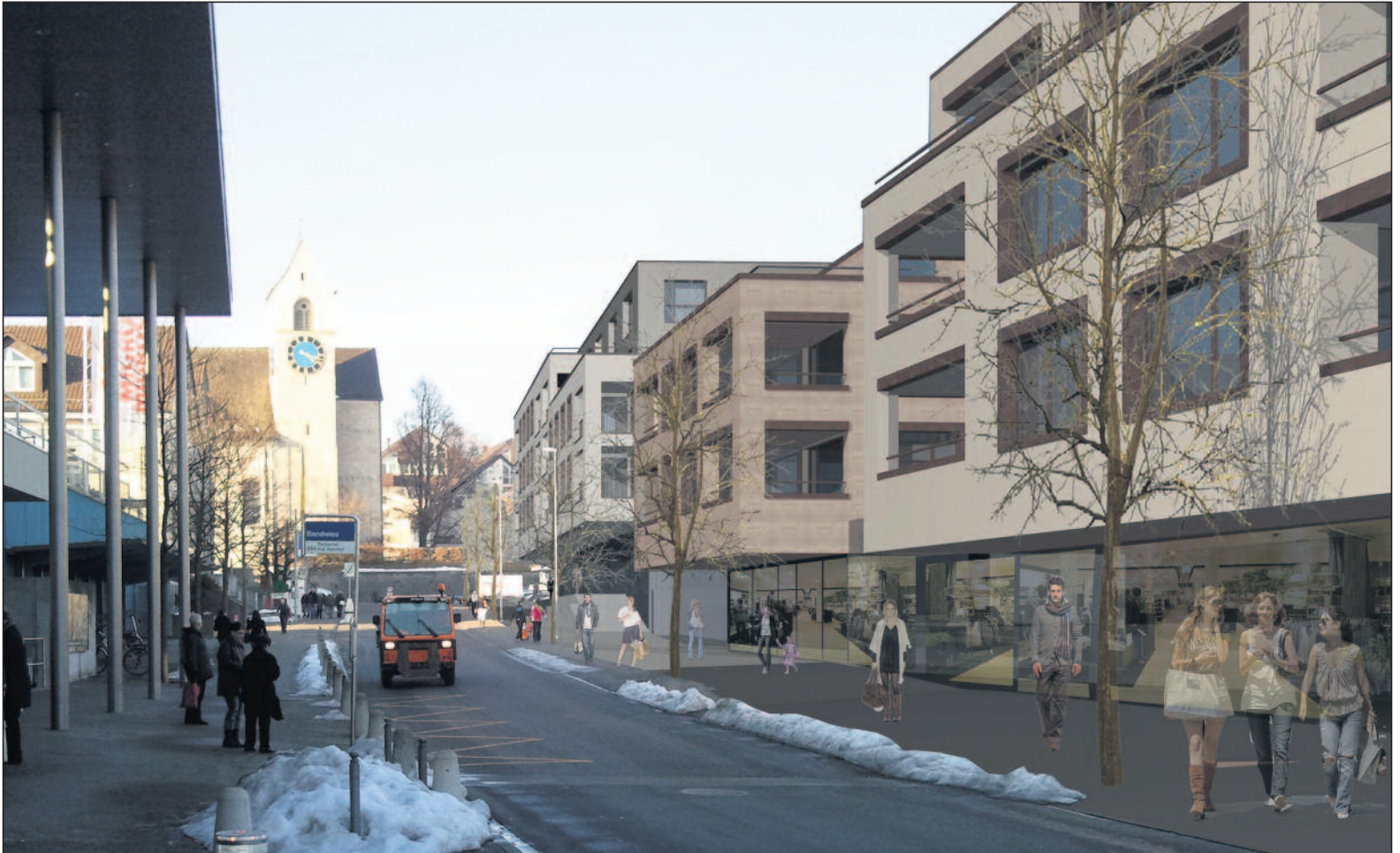
Die neue Überbauung an der Bandwiesstrasse wäre ein wichtiges Gegenüber zu Märtege und Migros.
