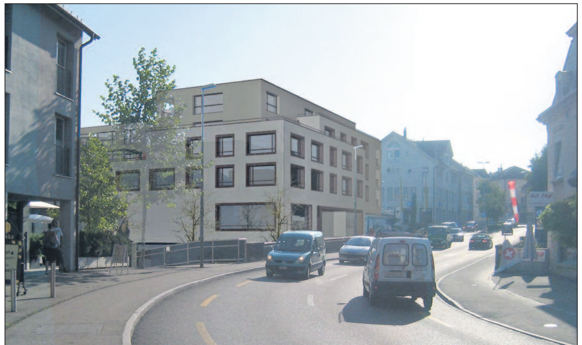
Eine rundum ansehnliche Fassade: Der Neubau anstelle des Manor.
