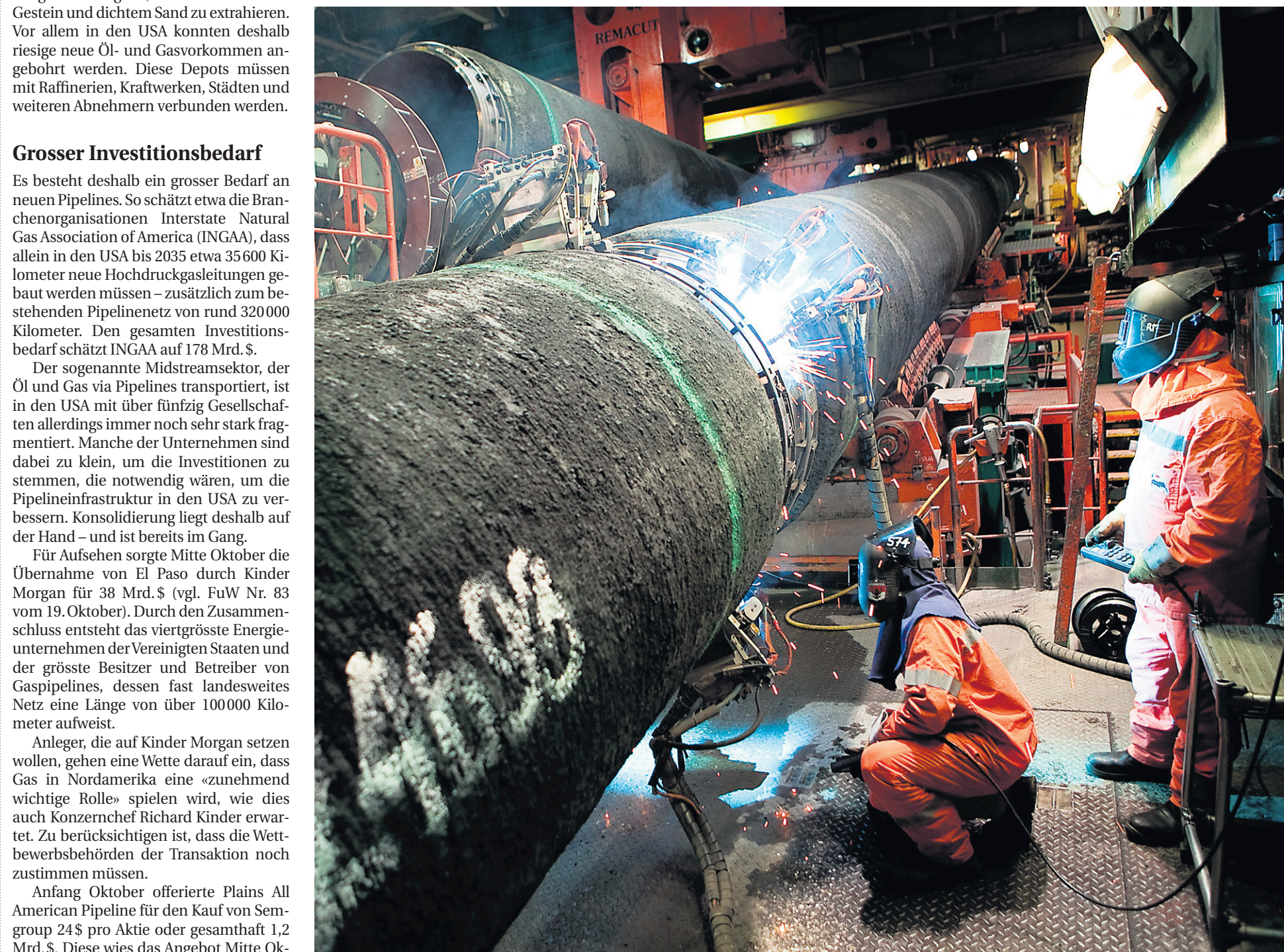
Zusammenbau der Rohre für die Nord-Stream-Pipeline. Für die 1224 Kilometer lange, zweisträngige Leitung werden insgesamt 200000 Rohre benötigt.
