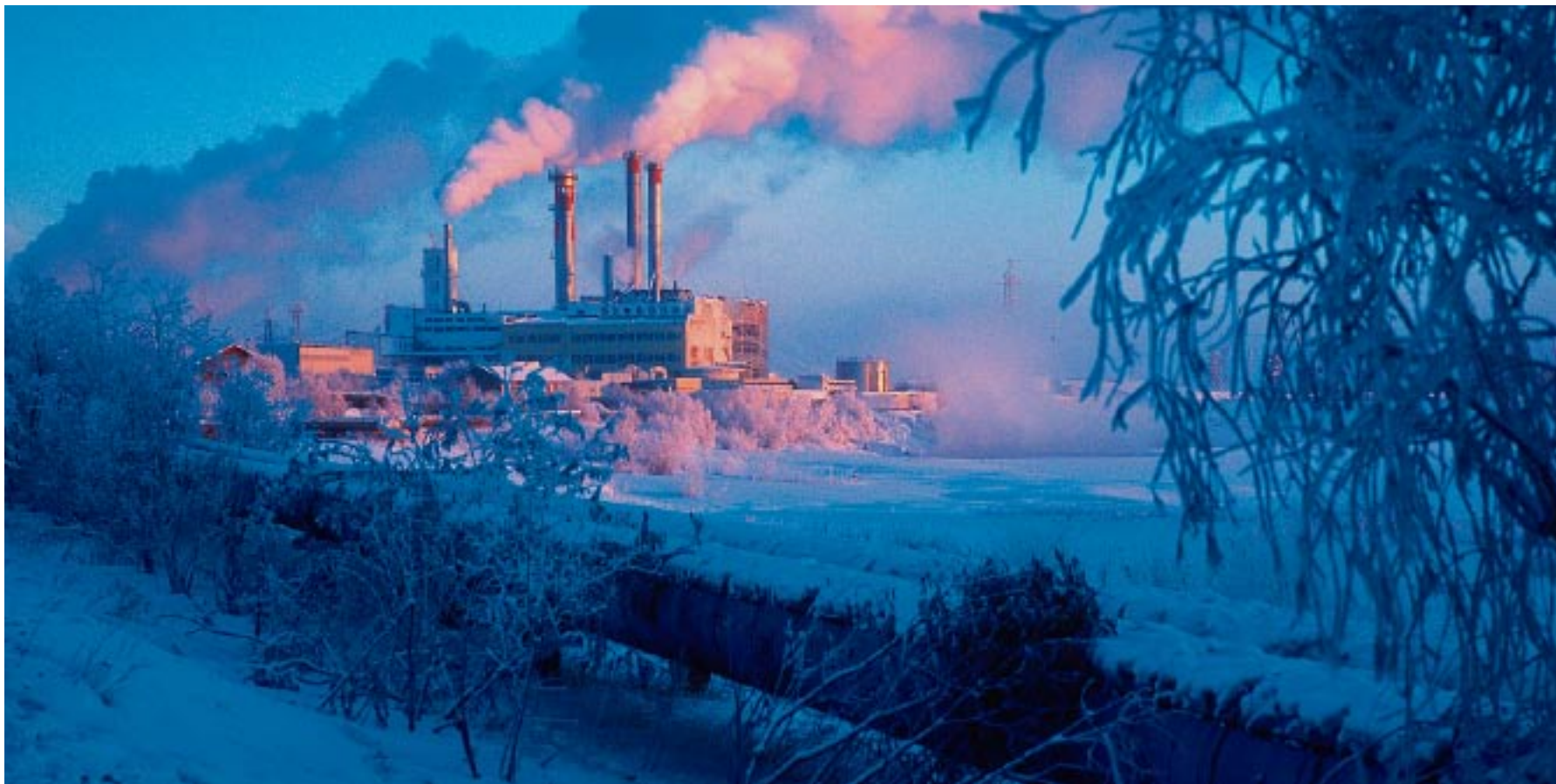
Energie bringt Wärme: Gasheizzentrale, die in Jakutsk, der kältesten Stadt Russlands, Warmwasser produziert. In Russland deckt Gas bereits über 50% der Primärenergie nachfrage.
