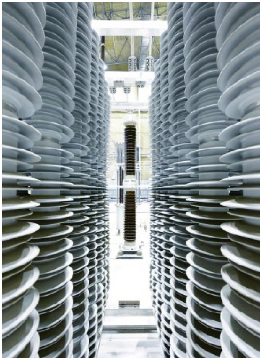
Überspannungsableiter in der von ABB mitgestellten Unterstation Gerus in Namibia.
