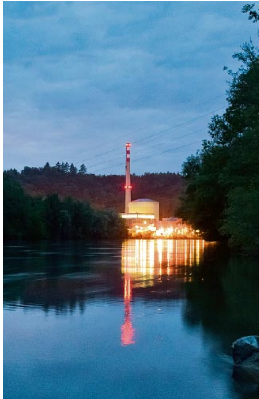
Laut BKW sollen die Lichter im Atomkraftwerk Mühleberg erst in zehn Jahren ausgehen.
