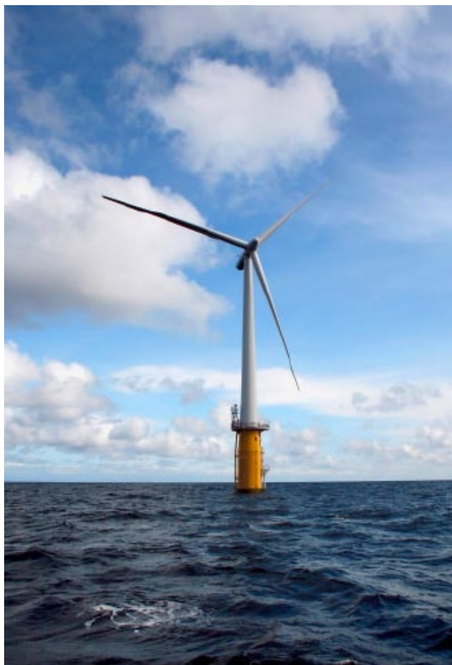
Hywind – die von Statoil entwickelte erste schwimmende Windturbine für tiefe Gewässer.
