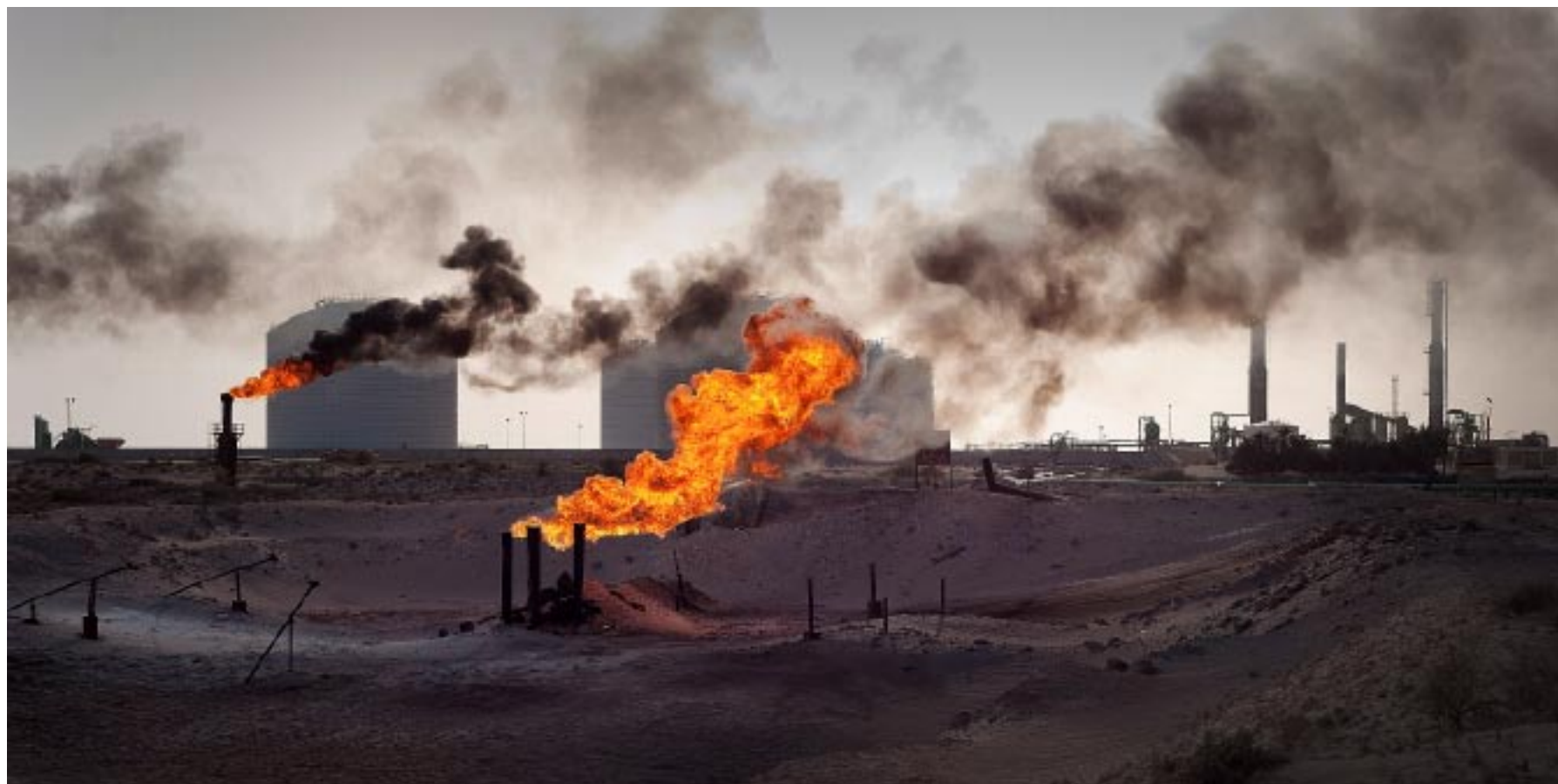
Beschädigte Raffinerie der National Oil Company in Zuitina: Durch den Bürgerkrieg in Libyen fiel 2011 die ganze dortige Ölförderung aus. Saudi-Arabien sprang ein und stopfte das Loch.
