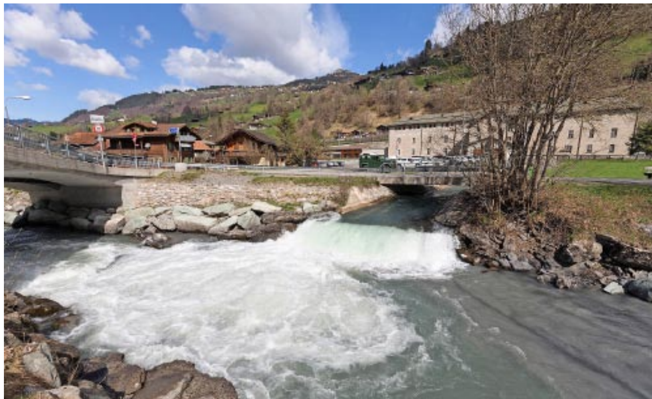
Die Landquart mit dem Kraftwerk Küblis (rechts im Hintergrund): Das Projekt «Chlus» verbessert auch die Wasserführung des Flusses.
