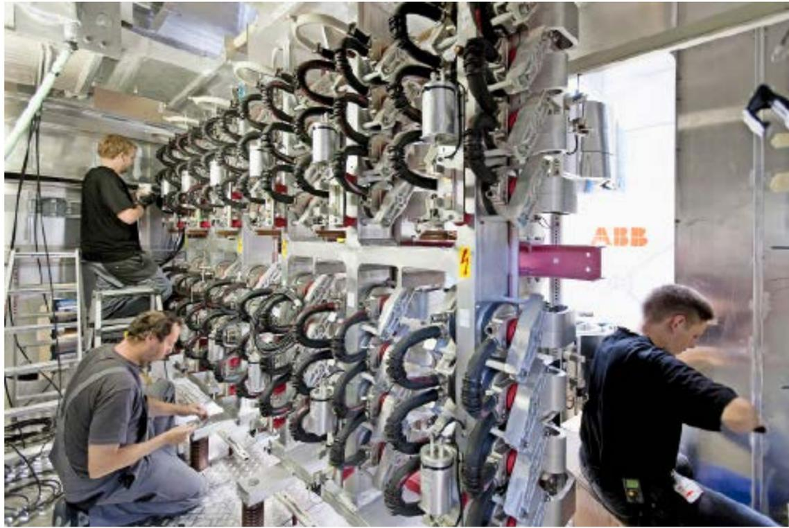
Die Aufträge nehmen bei ABB trotz unsicherem Umfeld kräftig zu: Installation eines Konverters für eine Aluminiumschmelzanlage.
