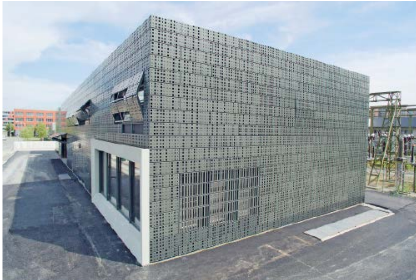
EWZ-Unterwerk Oerlikon: Platzsparende gasisolierte Schaltanlagen von ABB erlauben die Integration in einen neuen Netzstützpunkt.
