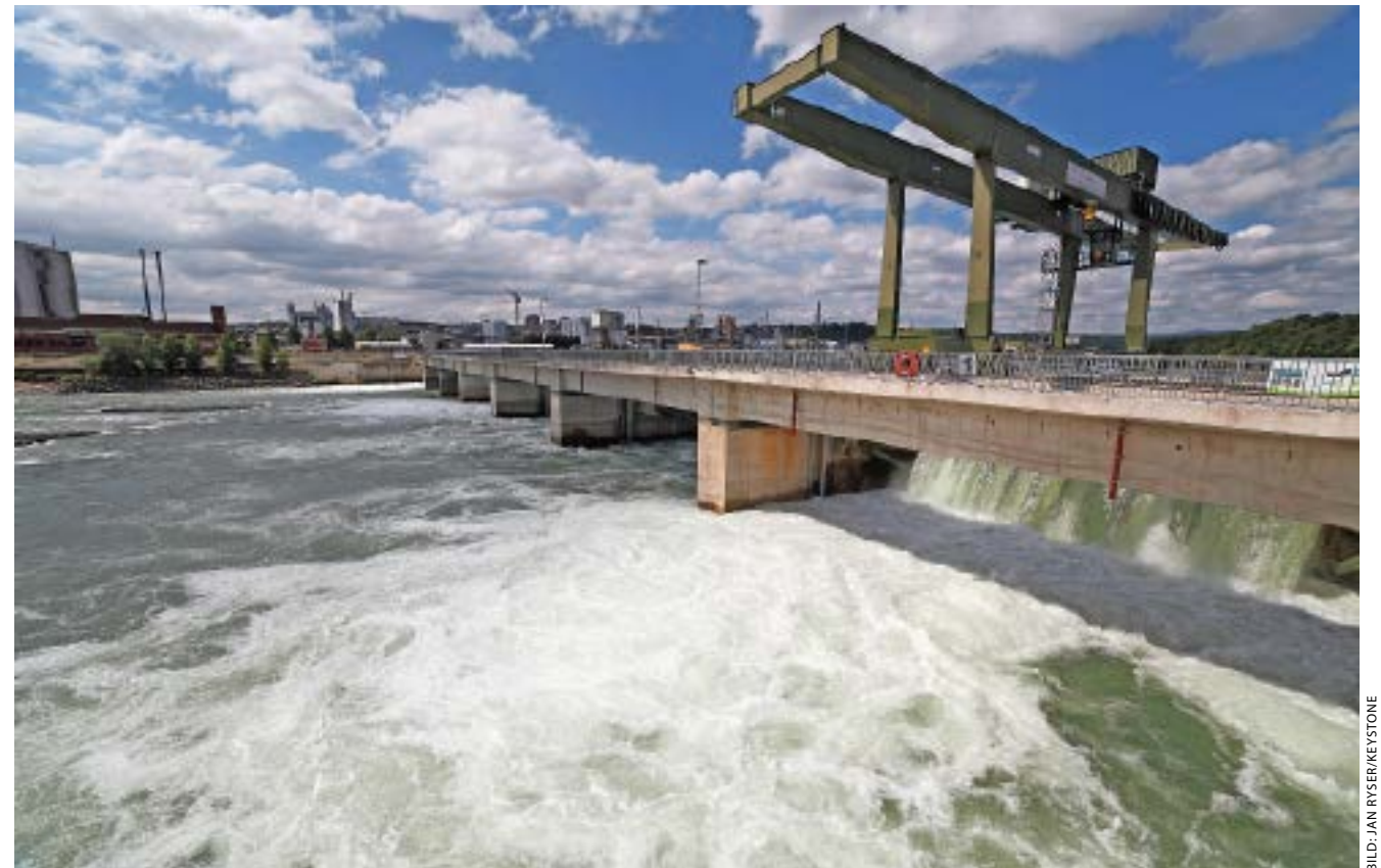
Kraftwerk Rheinfelden: Trotz gestiegener Strompreise rentiert die Erzeugung aus Wasserkraft noch immer kaum.
