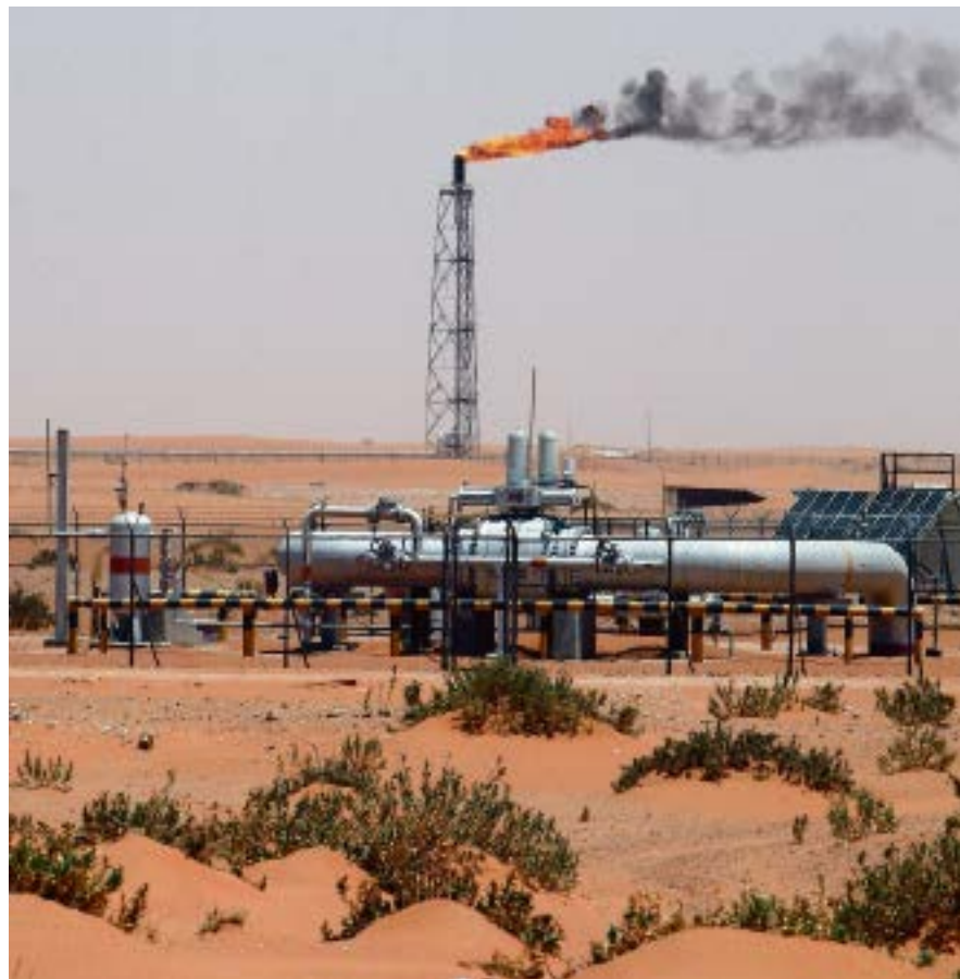
Gasabfackelungsanlage auf dem Ölfeld Khurais von Saudi Aramco.
