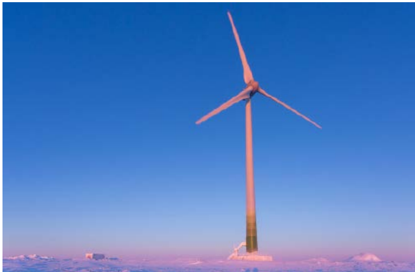
Erneuerbare Energie in unwirtlicher Umgebung: Windturbine, die Glencores Raglan-Nickelmine in Quebec mit Strom versorgt.
